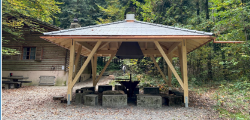
Aegerten: Mit dem neu errichteten Dach ist die Grillstelle beim Waldhaus der Burgergemeinde nun wettergeschützt.
